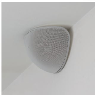
Montage onder dakrand
