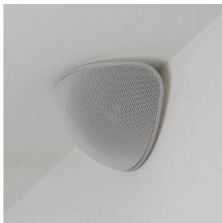
軒下に据え付け
